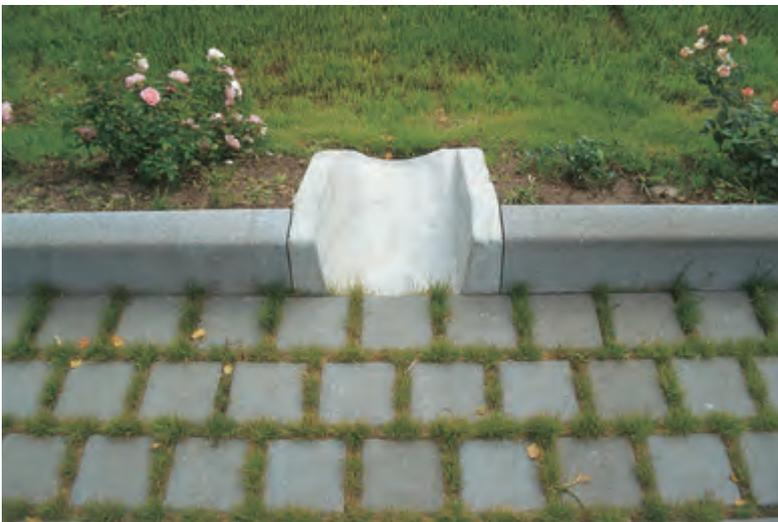
*Abb. 136: Beispiel für eine hydroaktive Pflasterfläche aus Betonsteinen mit kapillar wirksamen begrünenden Füllmaterialien und einer zusätzlichen Entwässerung über einen Sickermuldenzulauf*
