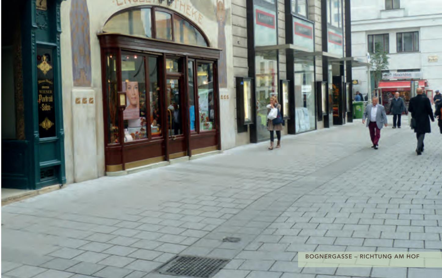
Auf Grund der Breite zwischen den Bebauungskanten in der Bognergasse wurde ein W-Profil ausgeführt. Die Entwässerungsachsen wurden teilweise optisch dunkler gehalten und in Form von „Klammern“ eine Gliederung in Längsrichtung hergestellt. Die Abmessungen wurden so gewählt, dass eine Abgrenzung für die Schanigärten gewährleistet ist. Die Teilung der Felder wurde so ausgelegt, dass die Beleuchtungsmasten jeweils in Feldmitte zu liegen kommen und eine optimale Ausleuchtung gewährleistet ist.
