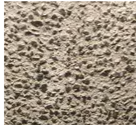
Abbildung 9: Waschbetonoberfläche mit dunkler Gesteinskörnung und der Verwendung von Titandioxid [Foto VÖZFI]
