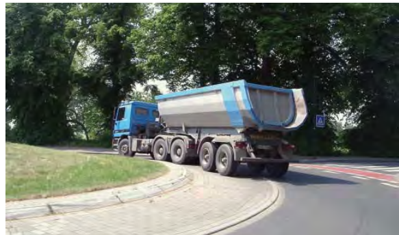
Kreisverkehrsanlage Buswendepplatz im Verlauf einer hochbelasteten Bundesstraße in Düsseldorf
