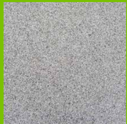
Gebundene Edelsplittbefestigung mit vollflächiger Versickerung
